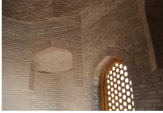
Şekil 12: Ayşe Bibi Kümbeti Güney Cephe Penceresi ve Güneydoğu Köşe Trompu.
