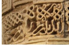
Şekil 10: Güney-batı köşe kulesi yazı kuşağı
