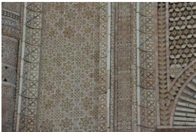
Şekil 8: Doğu cephe bezemeli tuğla levhalarından ayrıntı
