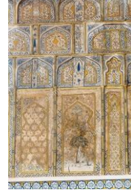
Şekil 21: Duvar süslemesinde kullanılan kalemişi levhalar
